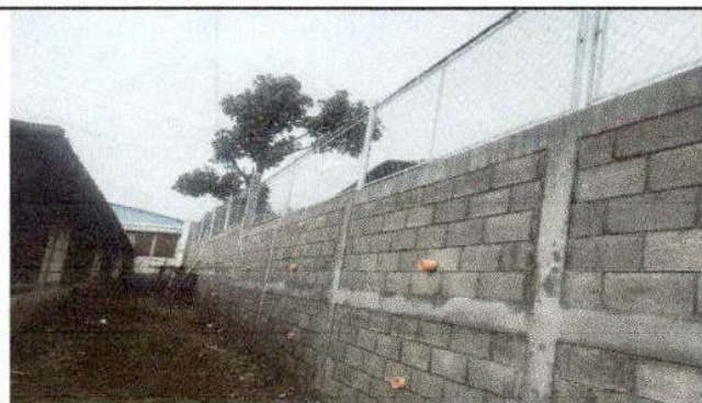
Foto 3: Finaliza la reparación del muro perimetral con malla HG del lado sur.
