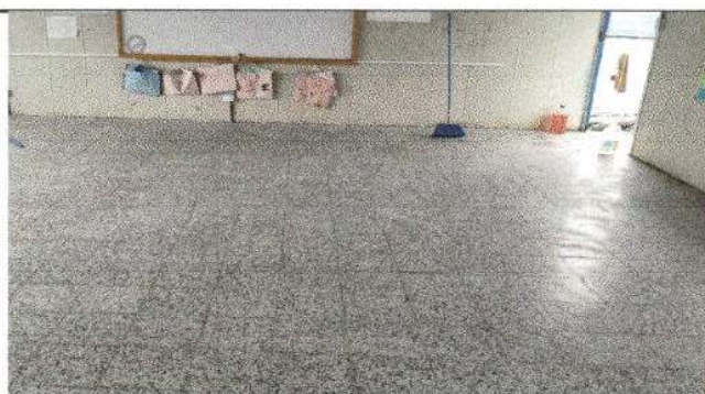
Foto 5: Terminación de piso de granito, lado sur.
