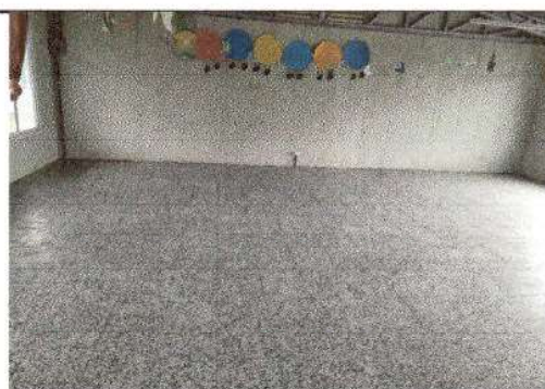
Foto 6: Terminación de piso de granito del lado norte.
