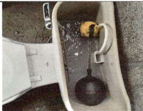
Foto 2: Finalización de los cambios de accesorios de los baños.
