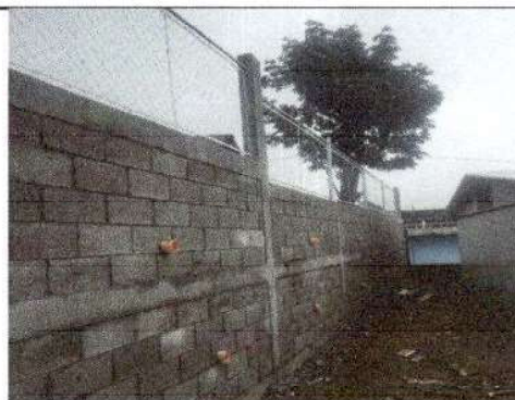
Foto 4: Finaliza la reparación del muro perimetral con malla HG del lado norte.
